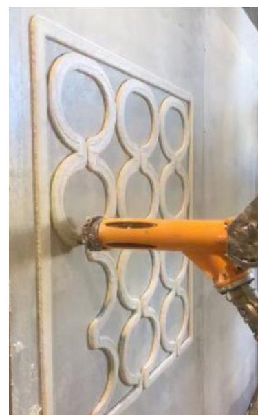
Elementos decorativos verticales en fachadas.
